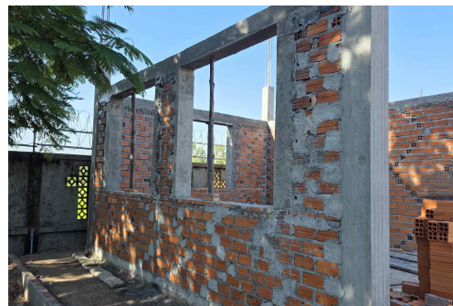
▣ 건축 중인 현장
